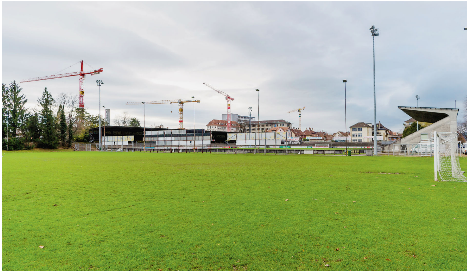
Trainingsfeld und Stadion Gurzelen sollen überbaut werden – mit einem grossen Anteil an gemeinnützigem Wohnraum. Matthias Käser/a
