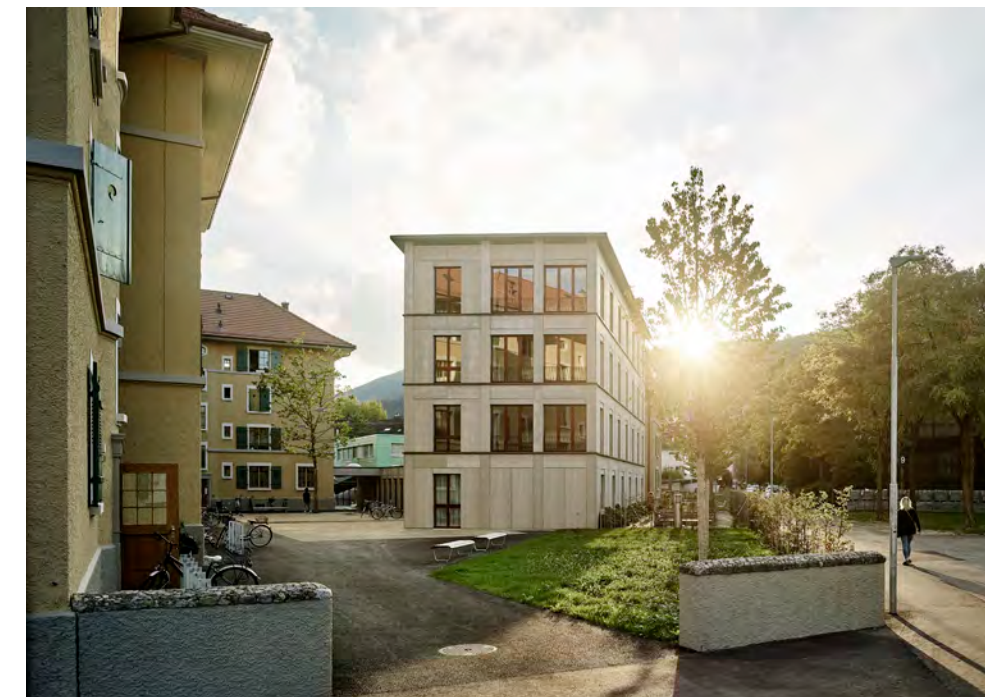
Ergänzen sich und bilden einen Innenhof: Alt- und Neubau Foto: Alexander Jaquement, Erlach
