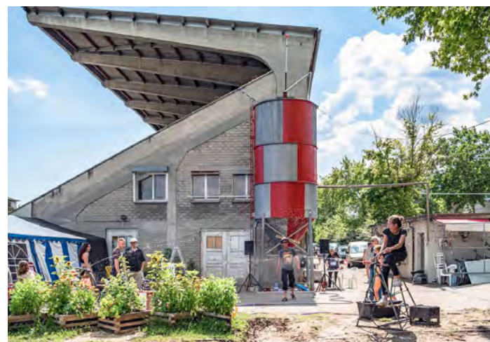
Regenwasser-Silo Rakete neben der Stadiontribüne Foto: Susanne Goldschmid
